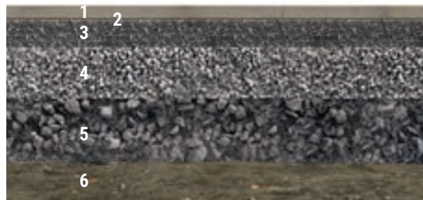
Abbildung 4: Aufbau gebundene Bauweise
