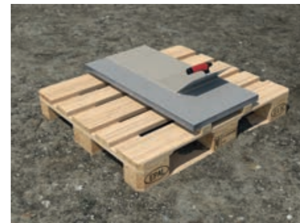
Kleber mit Zahnpachtel vollflächig aufbringen.
